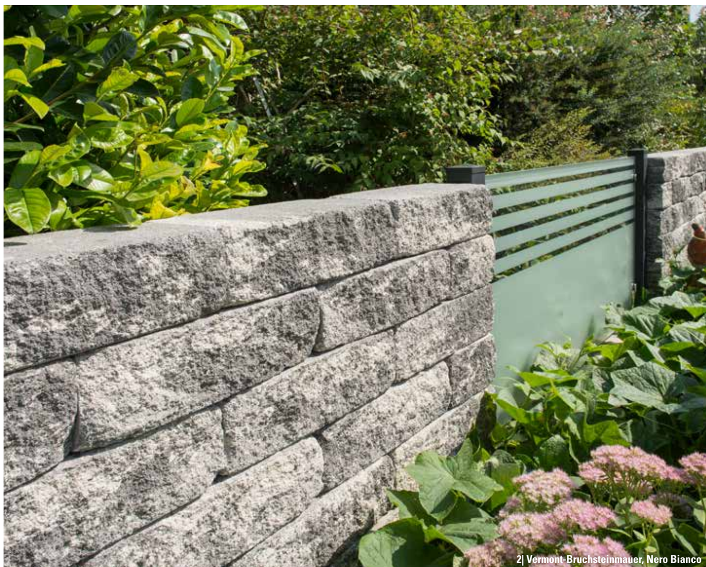
1 | Vermont-Bruchsteinmauer, Nebraska Kies
