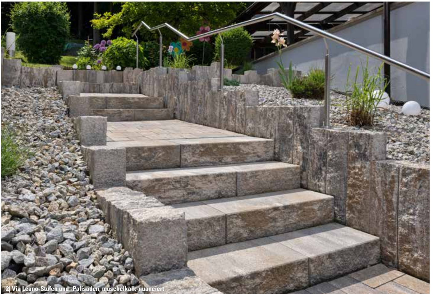
1| Via Leano-Stufen und Vermont-Bruchsteinmauer, Nebraska Kies
